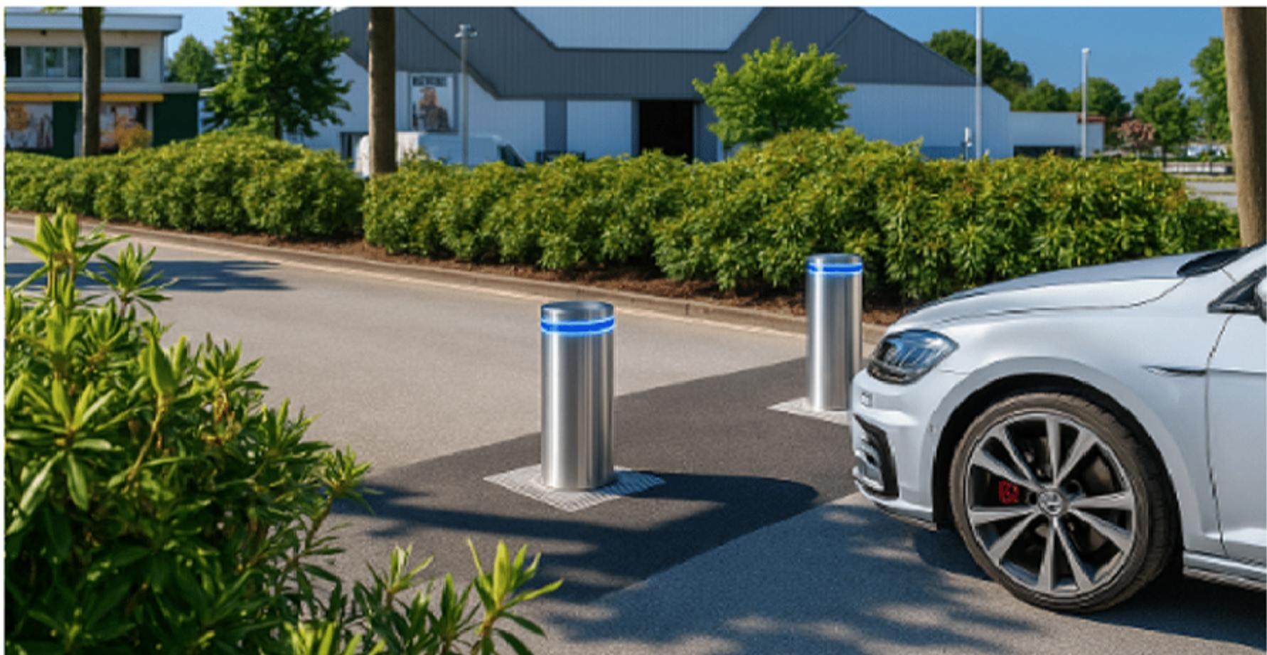
Un Dissuasore Automatico è un cilindro metallico automatico altamente resistente agli urti che viene destinato a delimitare le zone protette come deterrente agli accessi delle auto. I dissuasori sono altamente resistenti agli agenti atmosferici e sono dotati di un meccanismo in grado di eseguire la movimentazione a comando.
